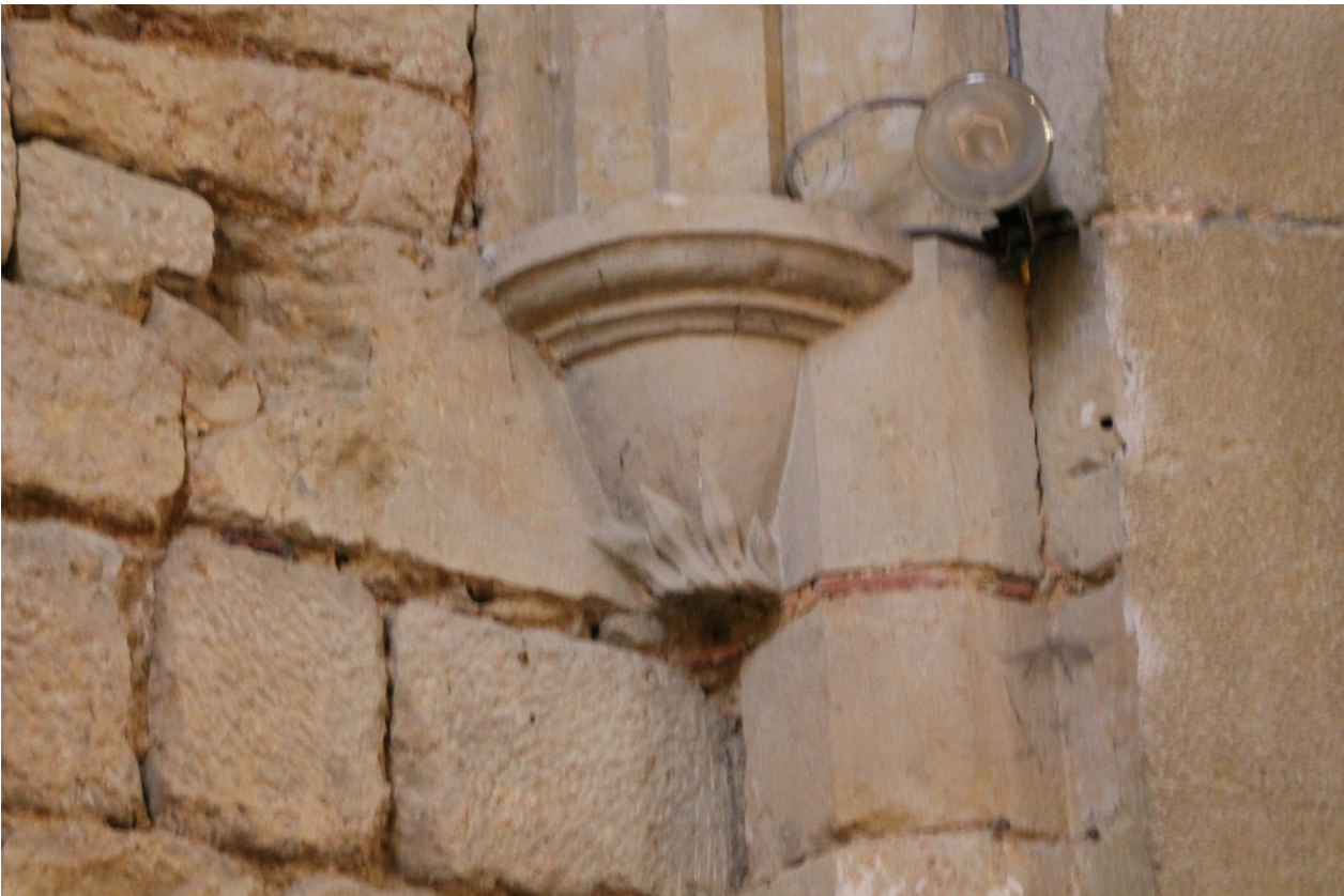
Console de la 2 e chapelle sud : chaudron et flammes. Photo S.A.
