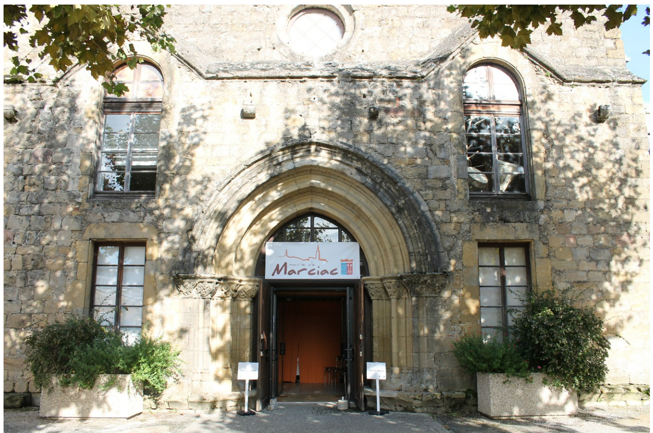
Façade du couvent des Augustins de Marciac (Gers) , vers 1350 et XVII e s.. Photo S.A.
