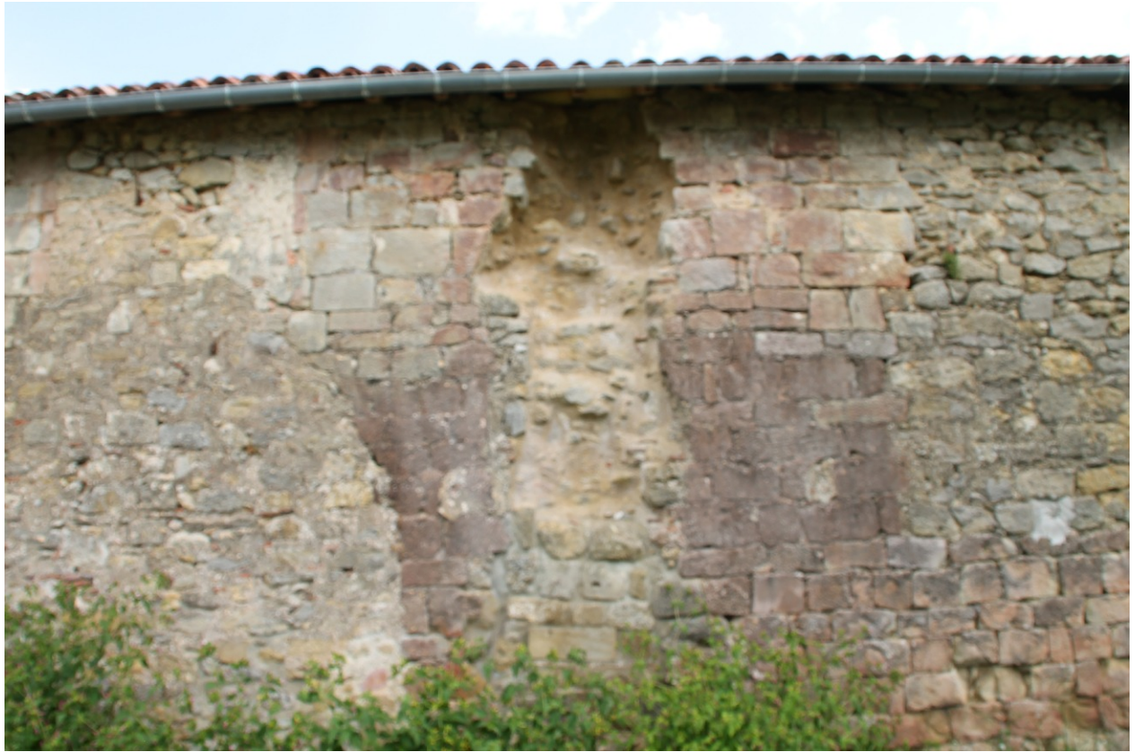
Entrée de la chapelle Est et arrachement de colonne engagée dans la nef. Photo S.A.
