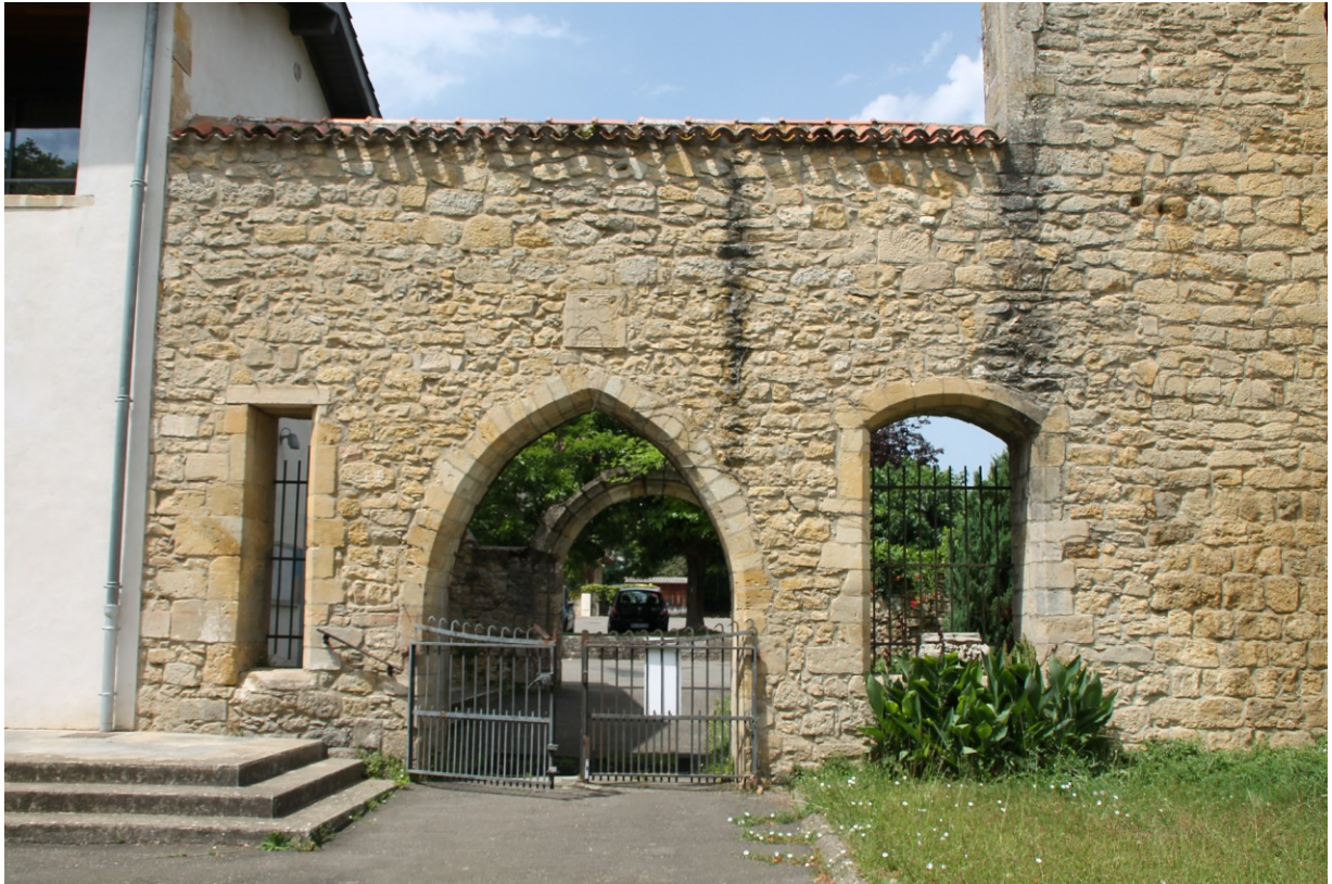
Façade de l'ancienne salle capitulaire. XV e -XVII e -XIX e s. Photo S.A.
